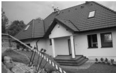
Fot. 2. Zniszczony dom dnia 28.05.2010 roku na rycinie nr 3 oznaczony literą B
