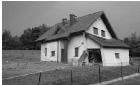
Fot. 4. Zniszczony dom dnia 28.05.2010 roku, na rycinie nr 3 oznaczony literą D
