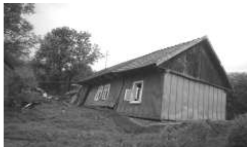
Fot. 3. Zniszczony dom dnia 28.05.2010 roku, na rycinie nr 3 oznaczony literą C
