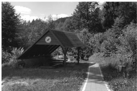
Fot.3. Nowa inwestycja na Ścieżce - wiata turystyczna. źródło: fotografował W. Jucha (2013)
