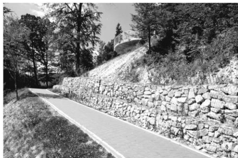
Fot.2. Nowa inwestycja na Ścieżce - punkt widokowy, zabezpieczenie skarpy przed osunięciem. źródło: fotografował W. Jucha (2013)
