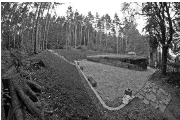
Fot.1. Schron Waligóra. źródło: fotografowała A. Kastelik (2013)
