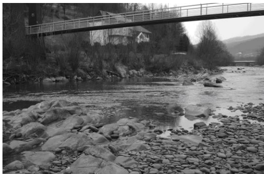
Fot.1. Wychodnia skalna w korycie Skawy w Su-chej Beskidzkiej odstonięta w wyniku wezbrania z 1997 r. (źródło: materiały własne).
