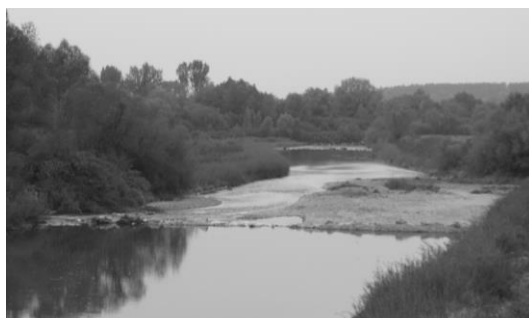
Fot. 3. Skawa w Witanowicach. W środku zdjęcia poprzeczny narzut kamienny; na dalszym planie drugi poprzeczny narzut; na prawym brzegu ujęcia wody pitnej w Witanowicach (źródło: materiały własne).
