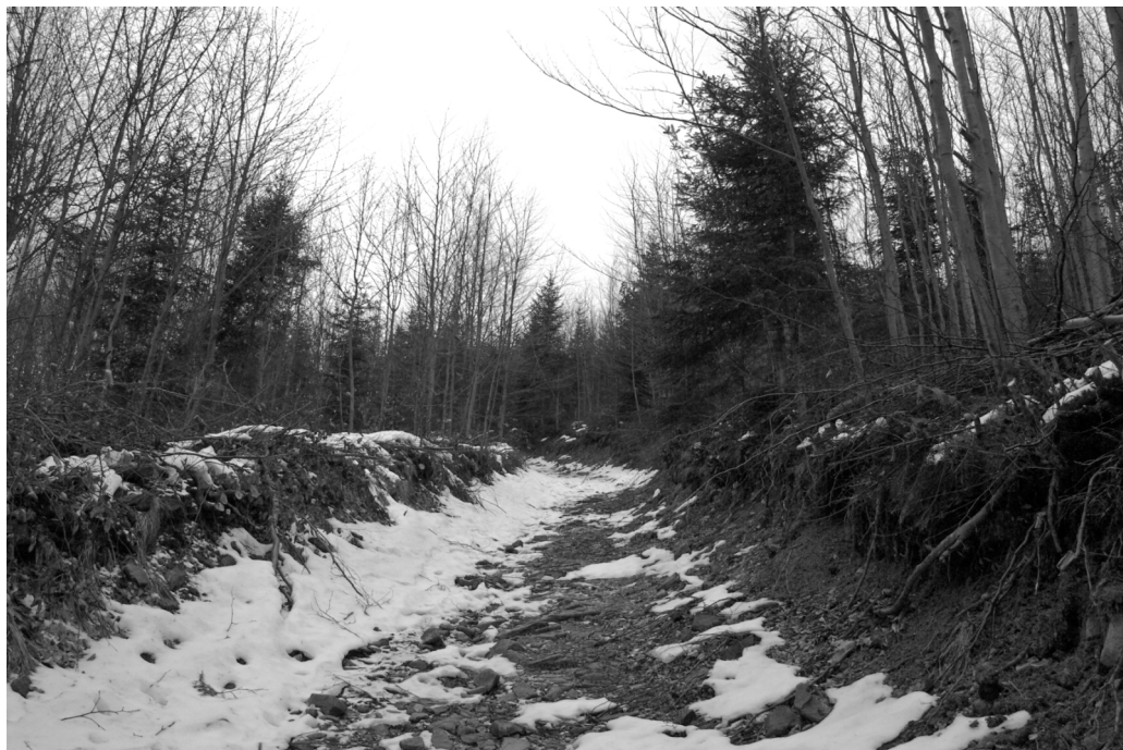
Fot.4. Droga stokowa na Kolisty Groń - szerokość ok. 5 m, wcięcie erozyjne w powierzchnię ok. 1,5 m. (źródło: fot. W. Jucha, 2017)
